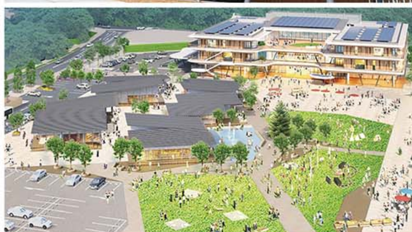
② 2025年3月大野駅西口に商業施設がオープン。飲食店や物販店、コンビニエンスストアの他に屋内キッズスペースや芝生の広場もある。新たな町の顔として賑わいの中心地。
